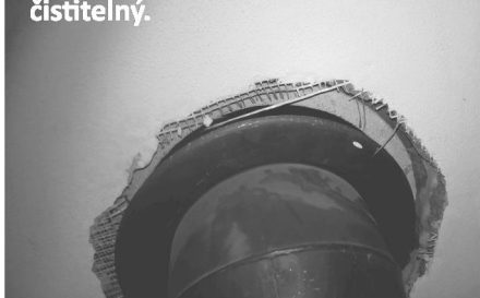
Špatné napojení na sopouch - netěsní a není čistitelný.
